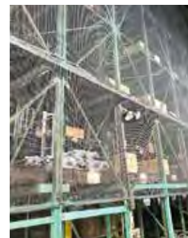
防護ネットによる 落下防止策
